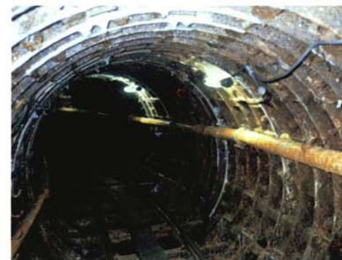
トンネルのシールドセグメント
